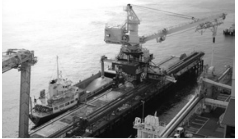
本年5月に導入した内航船積み込み機能を備えた荷役機械で100万トンを目指す
